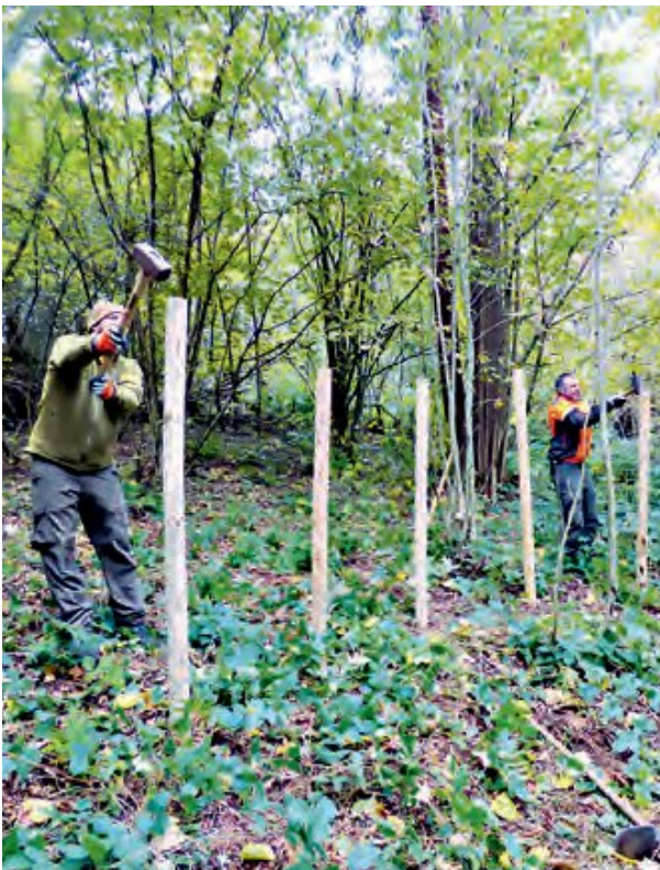
Errichtung einer Wildschweinfalle
