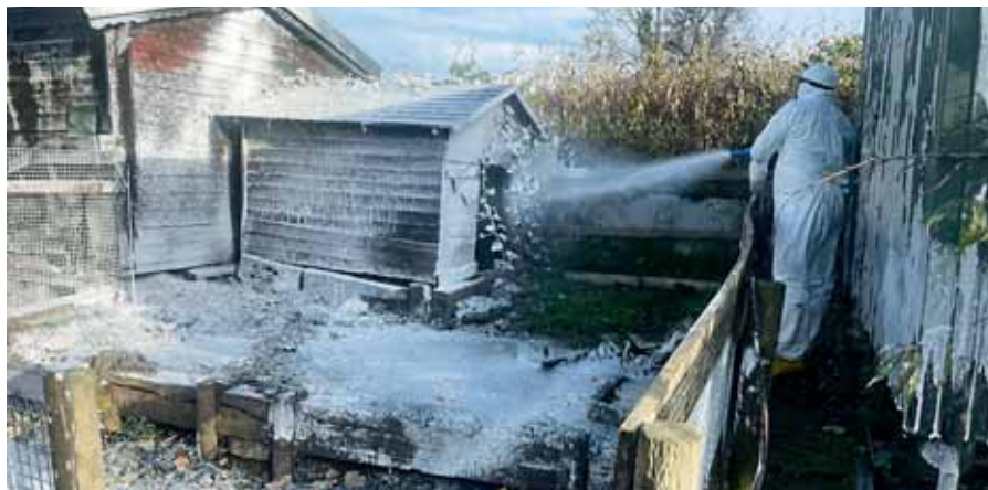
Schaumdesinfektion nach erfolgter Bestandsräumung
